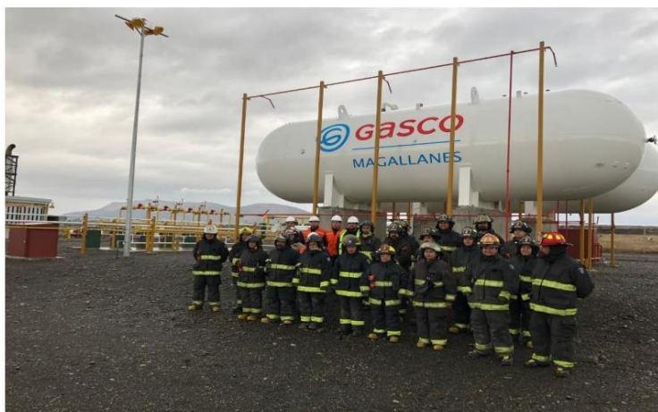
Figura 7 Visita de Cuerpo de Bomberos de Puerto Natales a instalaciones de la Central "Las Lenguas". Fuente: Adenda Complementaria.
