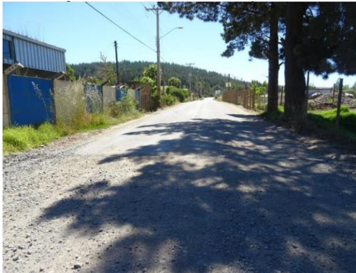
Fotografía 1: Situación actual de la Ruta J-80.
