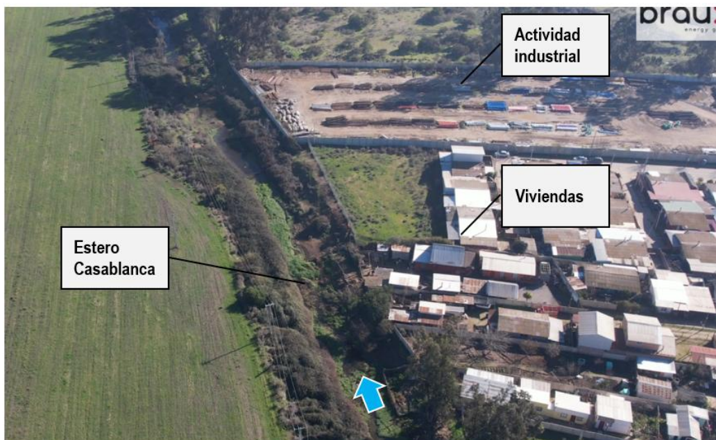
Imagen 21 Vuelo dron julio 2025 viviendas Casablanca Fuente: Anexo técnico recurso de reclamación DIA "Parque Fotovoltaico Manzano III - Reingreso"
