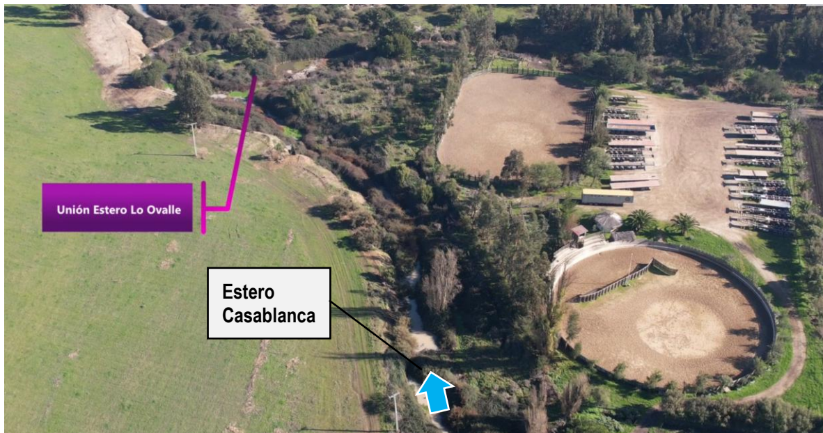
Figura 3-3. Imagen aérea – Registro N°3 (300 m aguas arriba del proyecto)
