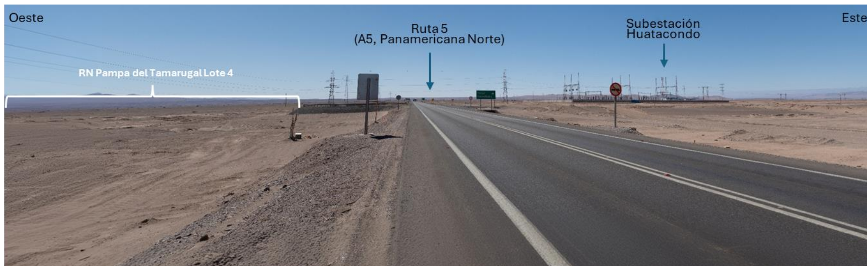
Fotografía 2: Ampliación del ángulo de visibilidad hacia el este de fotografía presentada para el PO-04. Ruta 5 en sector subestación Huatacondo
