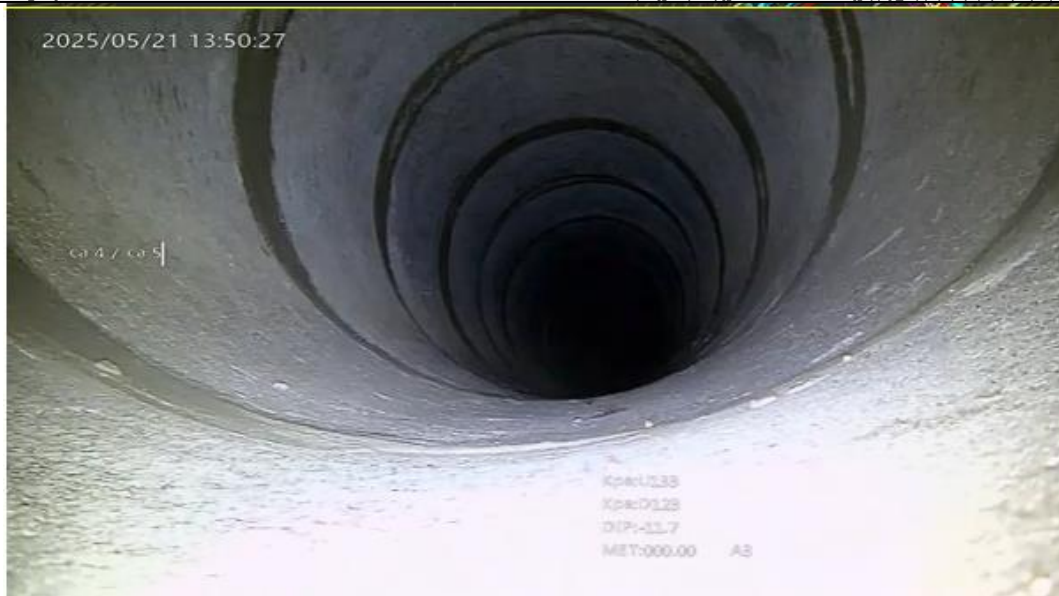
Figura 2-6 Colector Cornisa. Cámaras N°4 (CO-00-015) y N°5 (CO-00-016)
