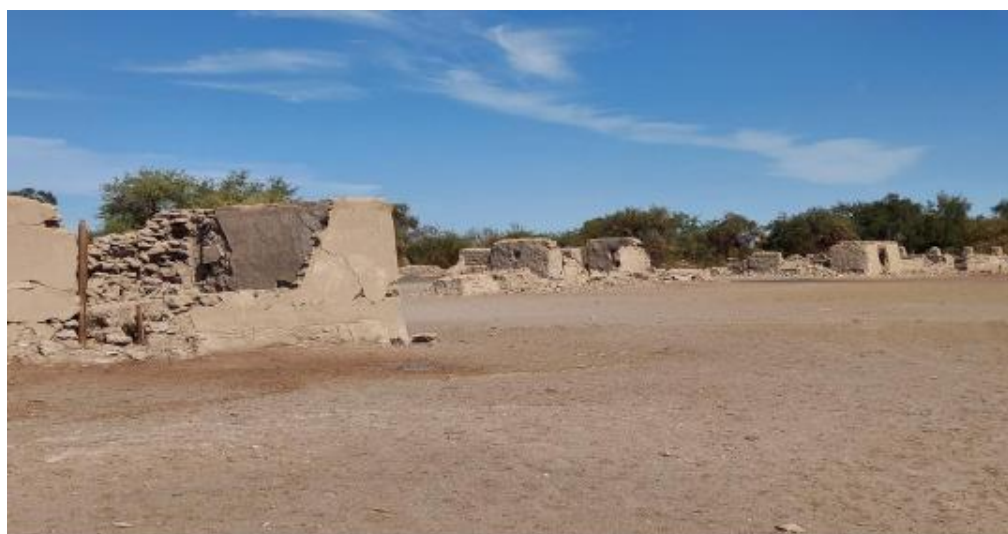
Figura N° Viviendas sector San Antonio. Fuente: Terreno 2021
