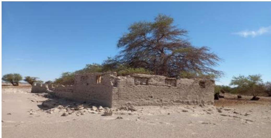
Figura N° Viviendas sector San Antonio, Fuente: terreno 2021
