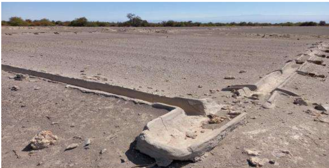
Figura N° resto de canales de riego para el cultivo agrícola, sector Santa Ana, fuente terreno 2021
