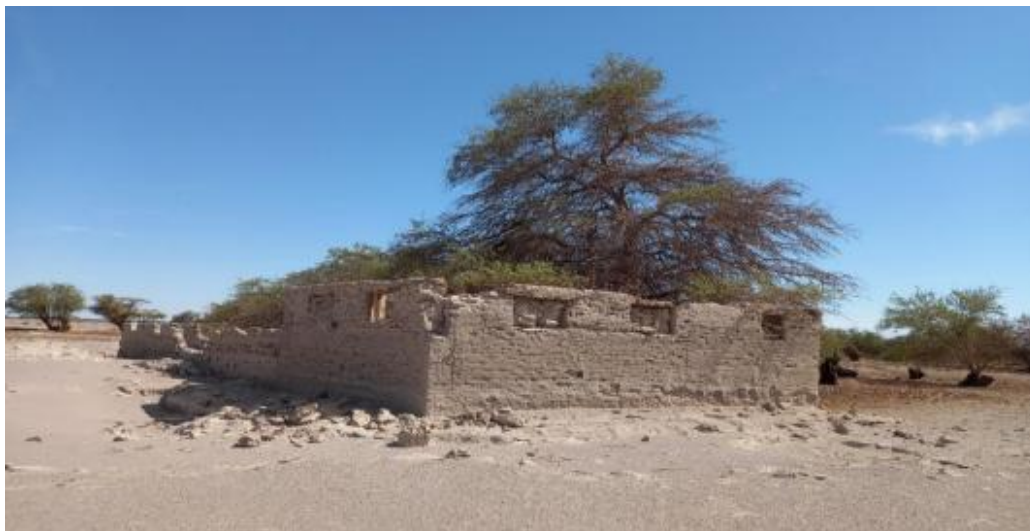
Figura N° Viviendas sector San Antonio, Fuente: terreno 2021
