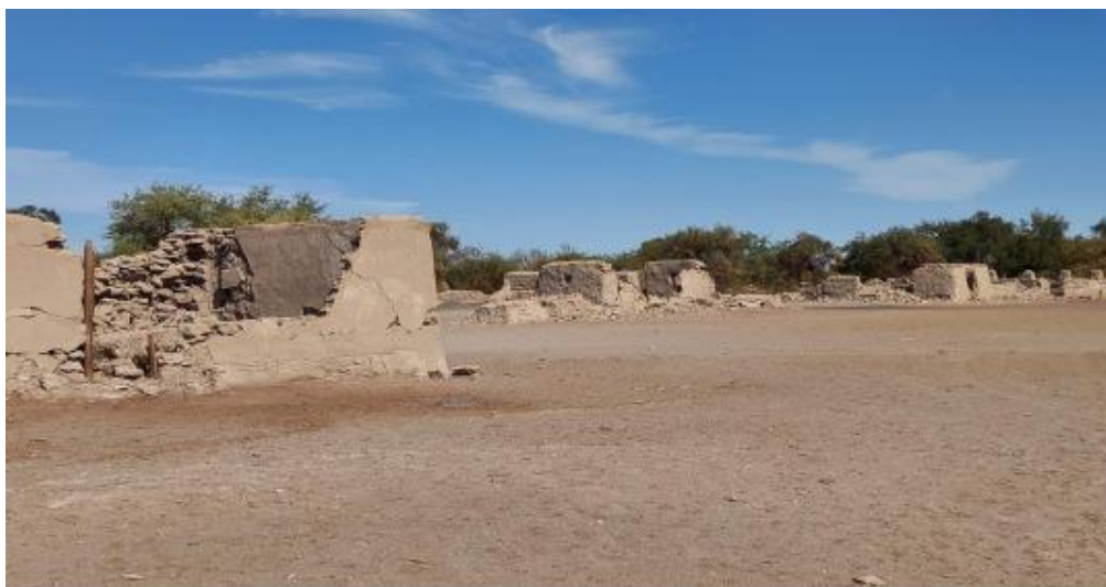
Figura N° Viviendas sector San Antonio. Fuente: Terreno 2021
