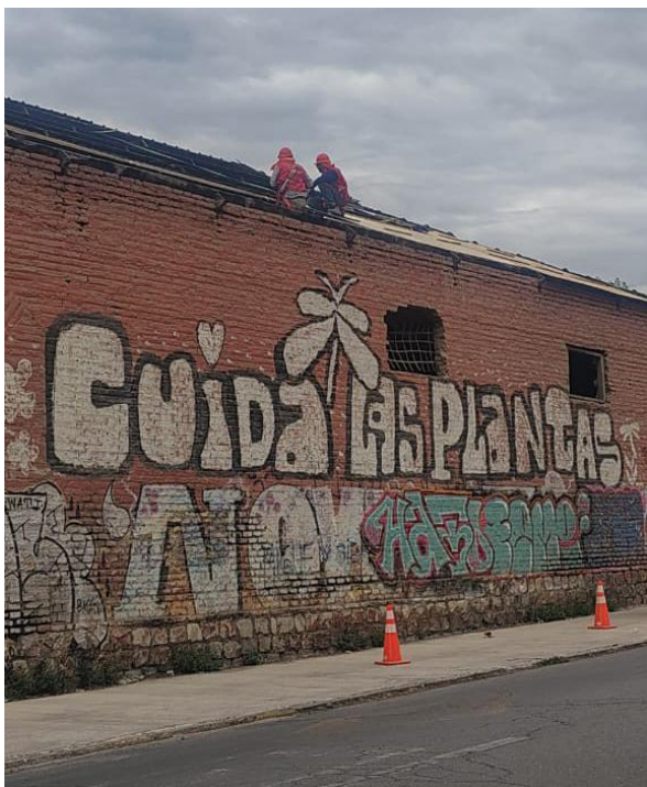
Figura 1: Trabajos en techumbre con exposición directa al entorno
