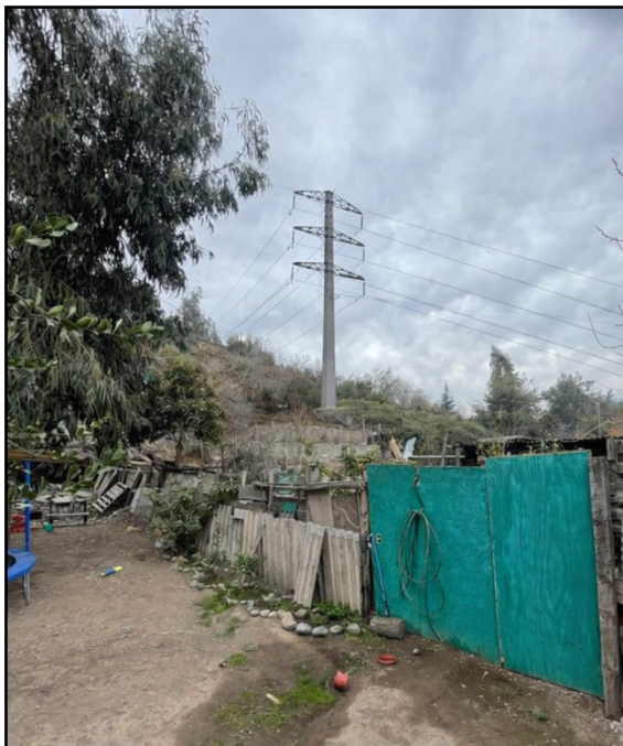
Imagen referencial del impacto visual que produce la instalación de las torres.
