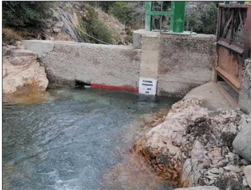
DIA, Figura 112: Fotografías bocatoma mejorada para entrega de caudal mínimo garantizado
