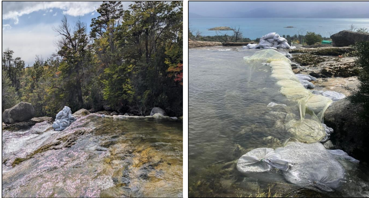
Imágenes N° 5,6 y 7: Registro de ejecución de faena de intervención y desvío del río Los Maquis.
