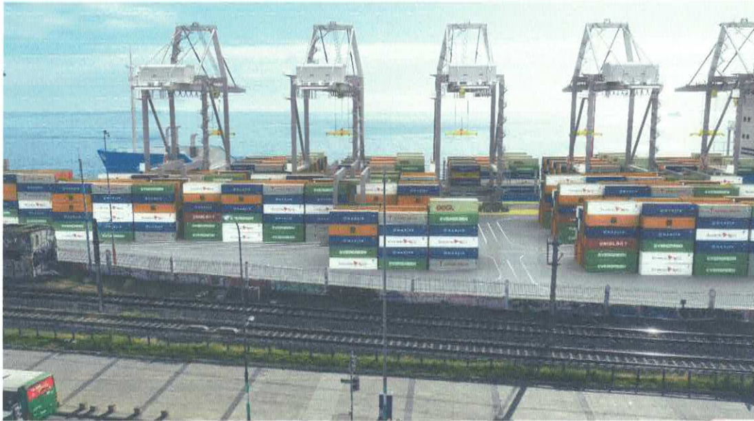
Fig. 15) PO20/ edificio DUOC Cousiño/UC con impacto de Sitio Costanera y alejamiento del mar del borde costero en Av. Errázuriz.
