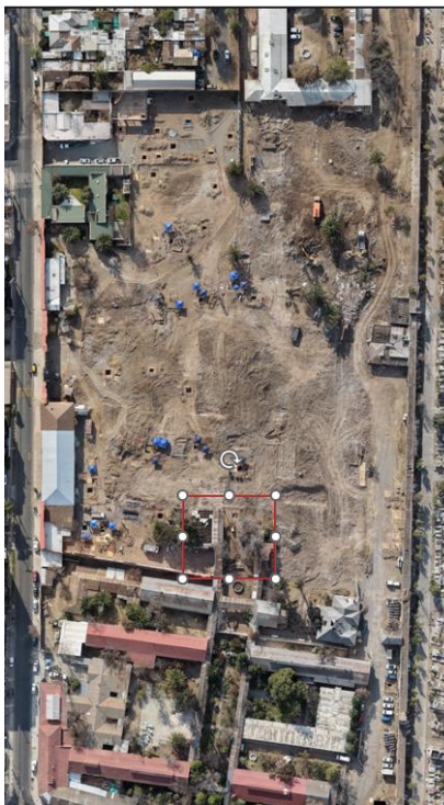
Figura 1. Avance de demoliciones masivas (en recuadro rojo lo que aún falta por demoler):
